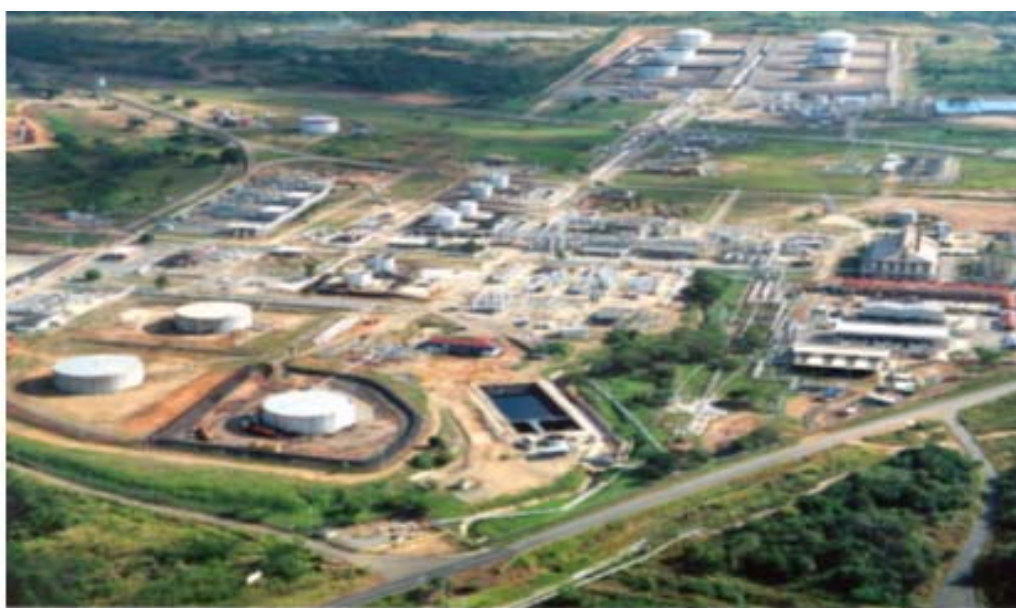
Figura 2.1 Vista aérea de una Estación de Flujo (Estación Principal Jusepín-2).
