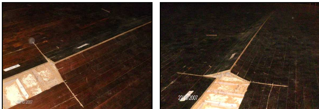
Figura 4.8: Levantamiento de listones del pavimento del Paraninfo. Fuente: Los Autores
