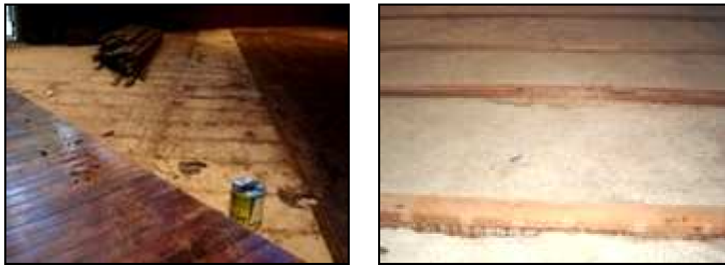
Figura 4.6: Situación de la Sala y nuevos durmientes instalados durante la restauración.
