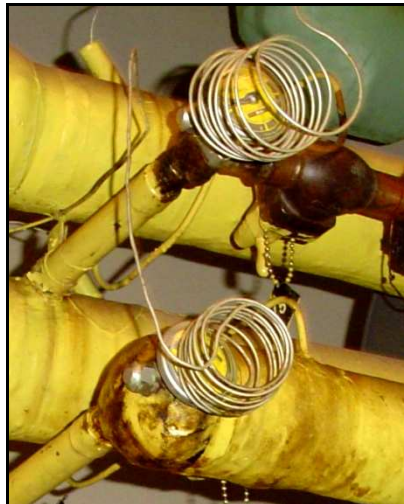
Figura 4.15: Válvulas de Expansión. Fuente: Los Autores.
