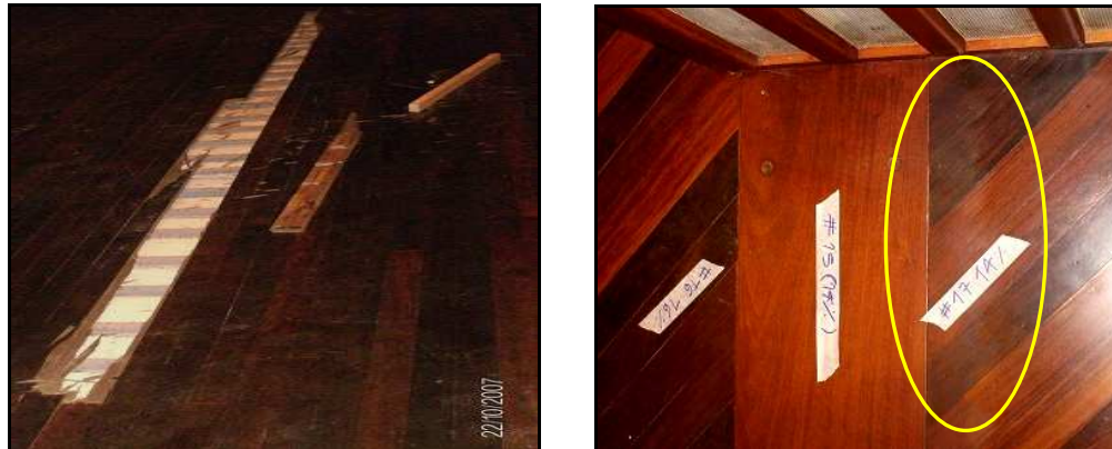
Figura 4.9: Remoción de piezas para sustitución y Detalle de acabado del piso. Fuente: Los Autores
