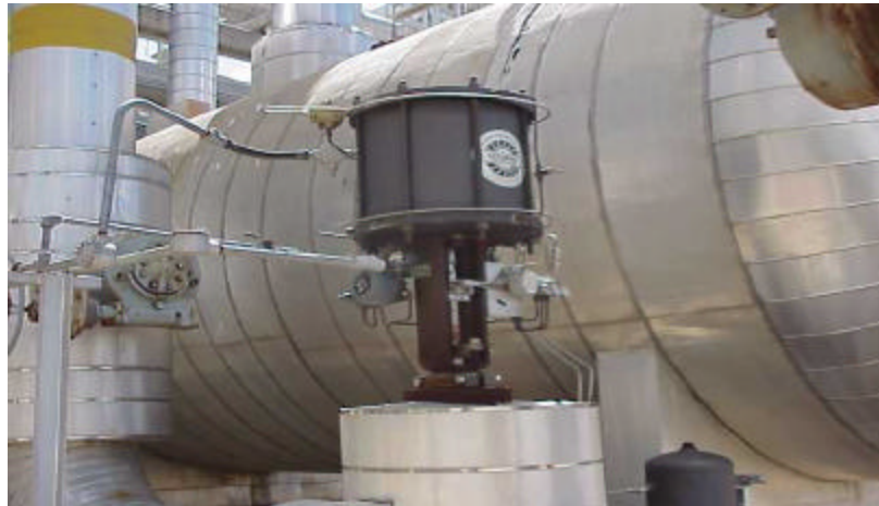
fig. 1.9 (Válvulas JT)
