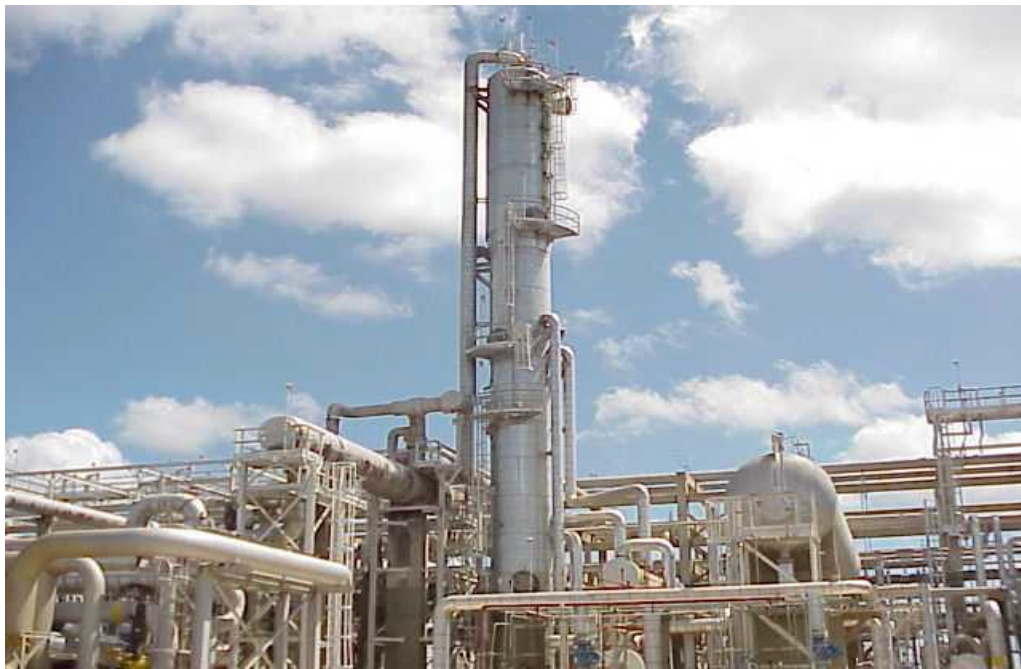
fig. 1.13 (Torre desetanizadora)
