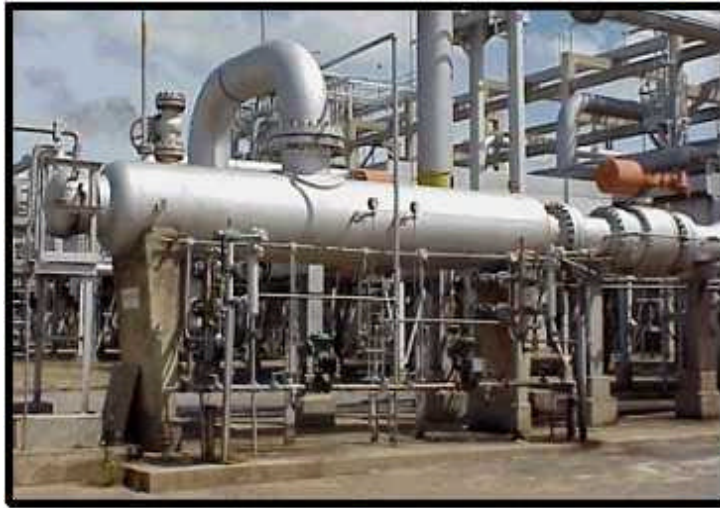
fig. 2.3 (Vista de los separadores de entrada al SDTEG) fuente: SIACCO.
