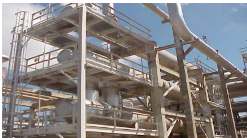
fig. 1.8 (Intercambiador gas caliente/gas de alta presión)
