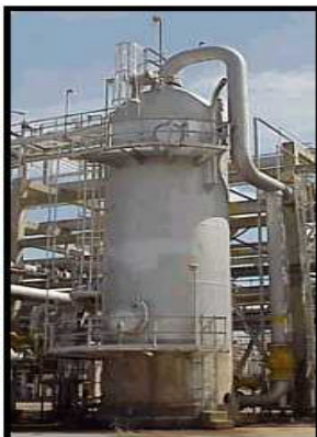
fig. 2.5 (Vista de la torre Contactora)
