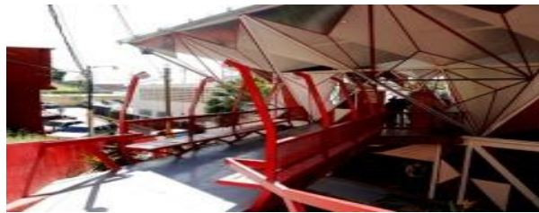
Segundo piso de la Casa de la Cultura “Simón Rodríguez”
