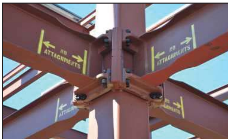
Foto No.3: Sistema ConXtech® ConXL™ Fuente: MURRAY, T. (2011).
