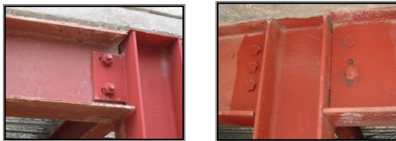
Foto No.3: Conexiones Flexibles de una estructura para estacionamiento ubicada en la ciudad de Caracas. Fuente: Gutiérrez, A. (2014)
