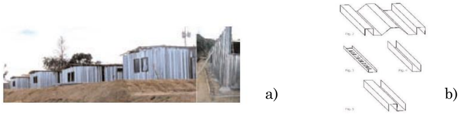
Figura 4: SIPROMAT. a) Estructuras Construidas, b) Láminas corrugadas.
