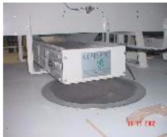
Figura 41. Salida de los silos
