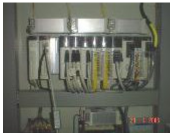
Figura 52. Ubicación del PLC con sus elementos
