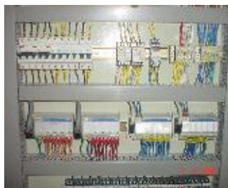
Figura 44. Sección de interconexión
