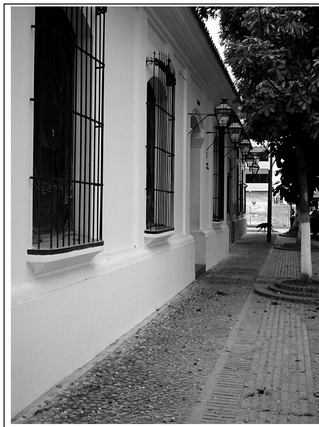
Imagen N° 20. . Fachada oeste de la Plaza Lara Foto: C. Rodríguez 2009
