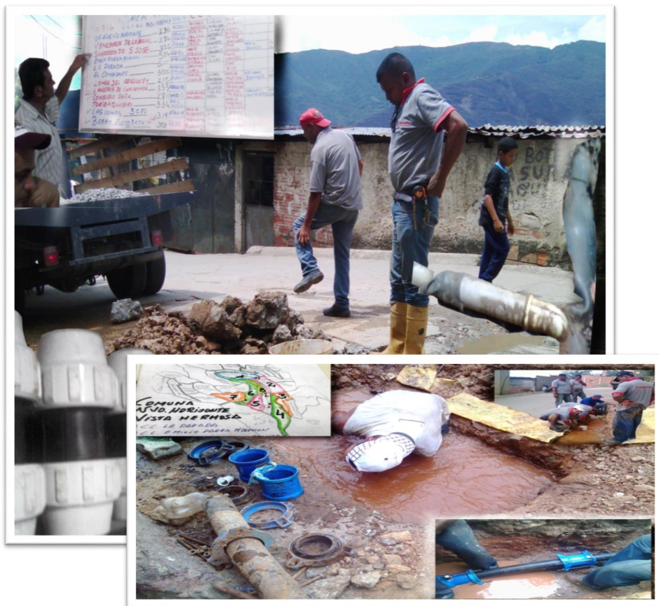
CUADRILLEROS EN EJECUCIÓN DE TRABAJOS EN EL CORREDOR FABRICIO OJEDA – NUEVO HORIZONTE
