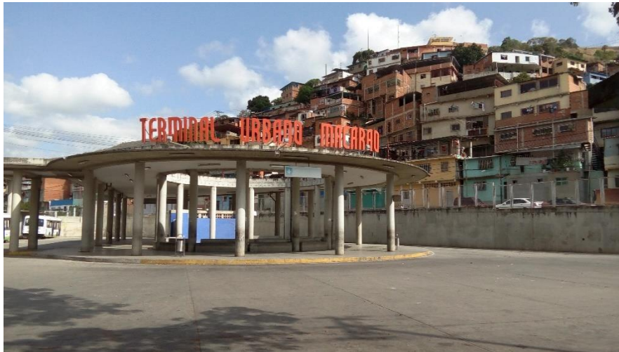
Imagen N°10 Terminal Urbano Macarao
