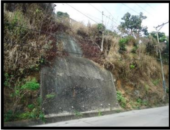
Imagen 26: Pantalla anclada (sector Luis Hurtado) Imagen 27: Muro de gavión
