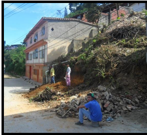
Imagen 13: Deslizamiento activo (Sector El Guamal)
