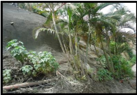
Imagen 28: Pantalla anclada (Sector Luis Hurtado) Imagen 29: Pantalla anclada
