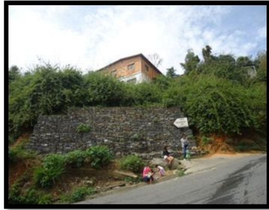
Imagen 26: Pantalla anclada (sector Luis Hurtado) Imagen 27: Muro de gavión
