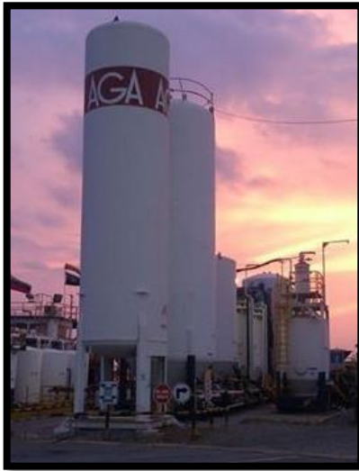
Figura 4 Planta de cemento, silos a presión y silos de gravedad [6]
