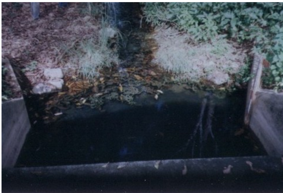
Foto 5.7. Pozo disipador de impacto y canal de descarga de la toma para riego. Embalse “El Cují”.
