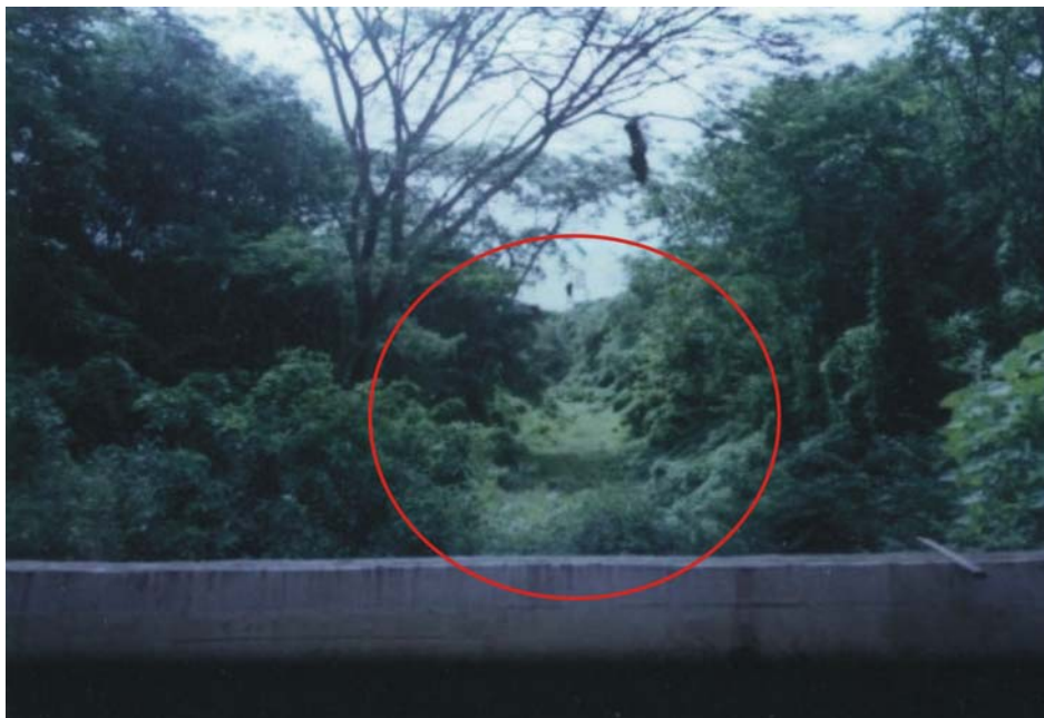
Foto 5.1. Canal de aproximación, con bastante cobertura vegetal. Embalse “El Cují”.
