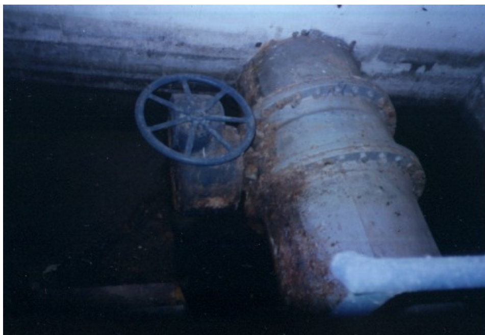
Foto 5.8. Válvula de emergencia (mariposa), se observa la inundación en la cámara de maniobras. Embalse “El Cují”.
