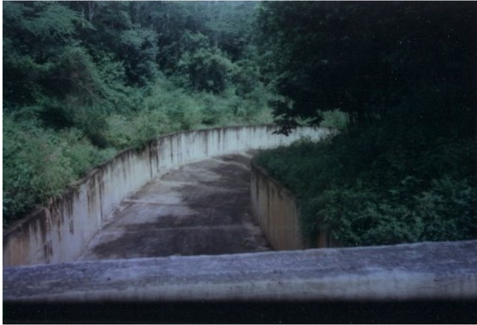
Foto 5.4. Canal rápido del aliviadero en buen estado. Embalse “El Cují”.
