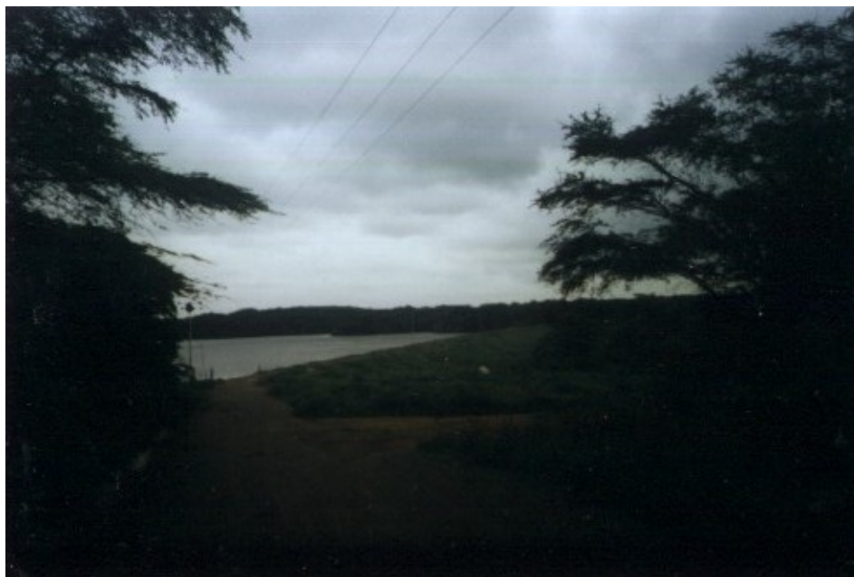
Foto 16. Talud de aguas abajo. Embalse "El Cují".
