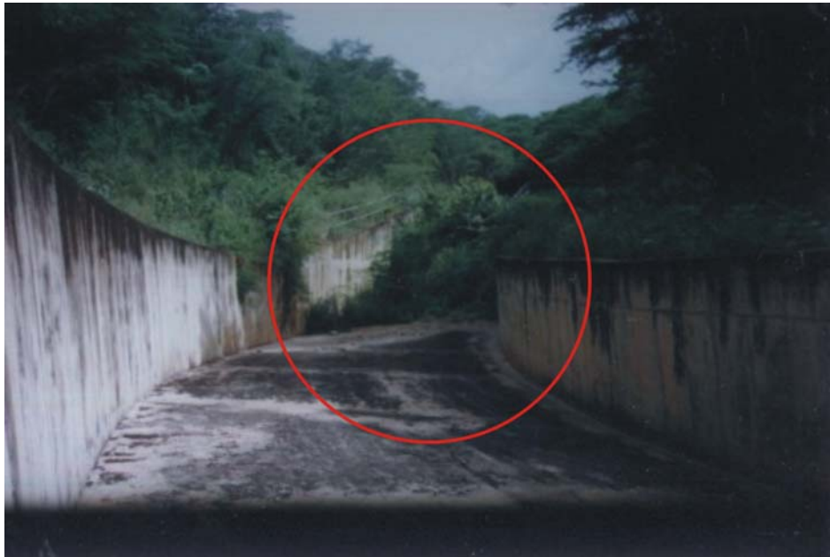
Foto 5.3. Canal rápido en buen estado, pozo disipador con abundante vegetación. Embalse “El Cují”.
