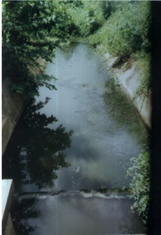
Foto 5.23. Canal de descarga de la toma para riego, obstruida por la densa vegetación. Embalse “El Andino”.
