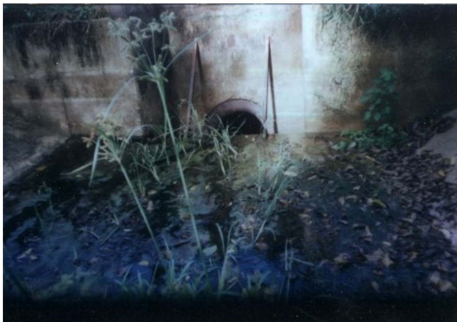
Foto 10. Tubería ubicada debajo de una carretera de tierra, canal de descarga de la toma para riego. Embalse “El Cují”.
