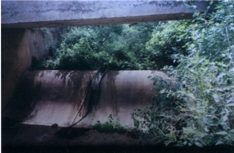
Foto 5.2. Vegetación a la entrada del cimacio. Embalse “El Cují”.
