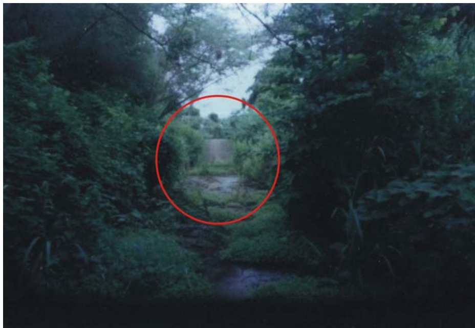
Foto 5.17. Cimacio y canal rápido con abundante vegetación. Embalse “El Andino”.
