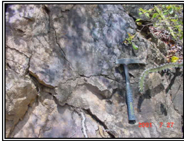
Figura 29: Espejos de falla reportados en campo.
