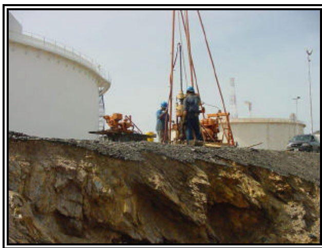
Figura 47: Ensayo de SPT, sobre talud fallado dentro de la planta.
