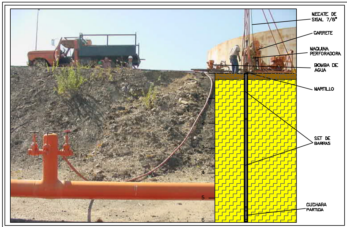
Figura 8: Sondeo con corrida SPT.
