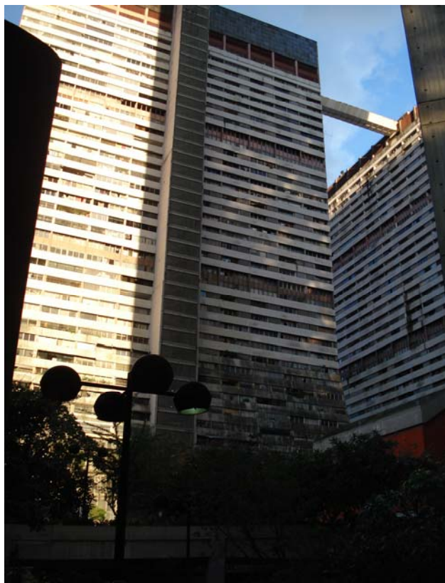
FOTO N° 2: CONJUNTO RESIDENCIAL Y EMPRESARIAL PARQUE CENTRAL. FUENTE: LENERIC MOLINA 19/02/10
