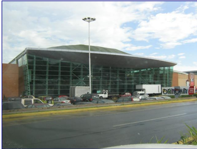
Imagen 1: Centro Comercial Orinokia, vista lateral.
