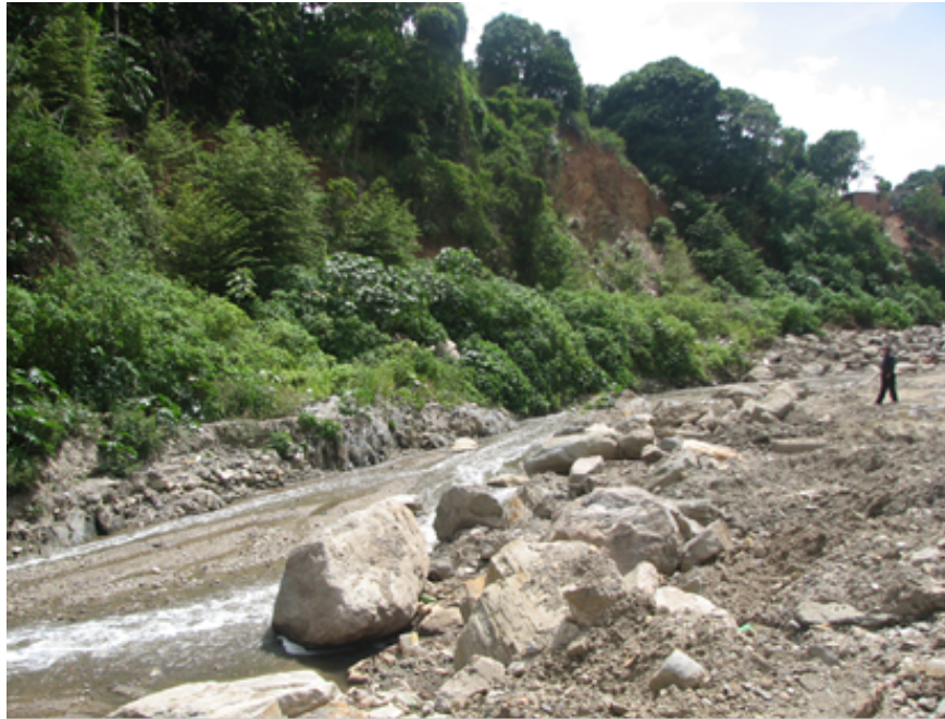
Figura 2.10. Fotografía del cauce de la quebrada Tacagua, arenera Minataca, C.A. Fuente: INGEOMIN-UCV (2009).
