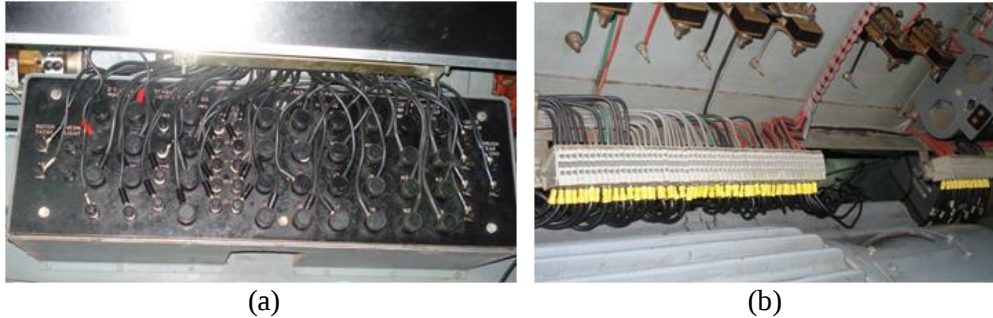
Figura 26. Verificación y reconexión de cables en la bornera.
