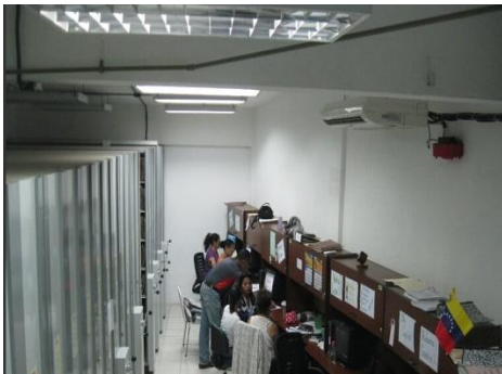
Figura B7. Iluminación
