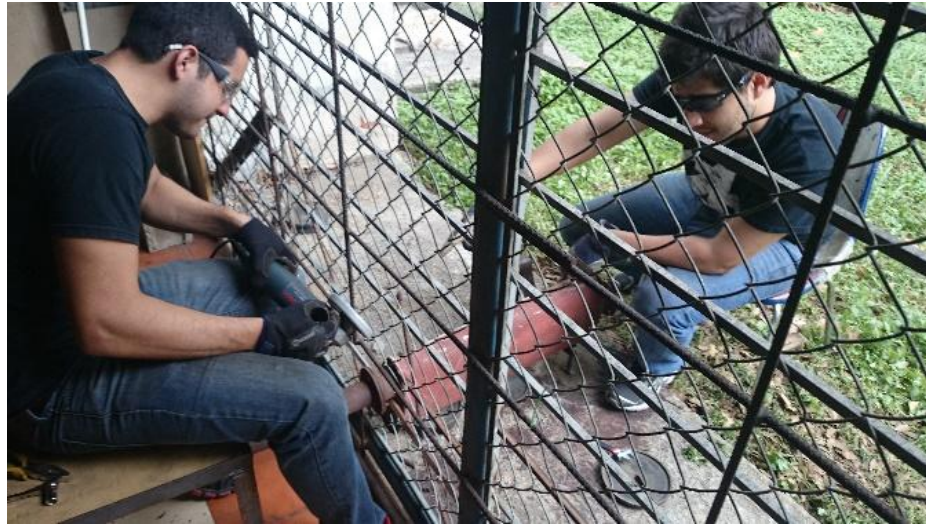
Figura A.4 “Instalación del silenciador”
