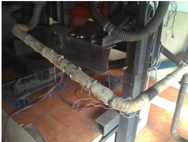
Figura 5.1 “Tubería de escape”
