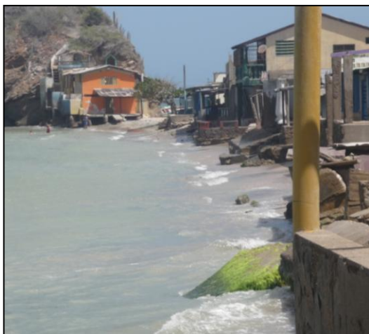
Fotografía 52. Afectaciones actuales (año 2016) a las viviendas.
