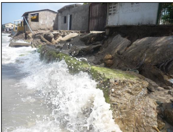
Fotografía 50. Vista de Oeste a Este del emplazamiento de infraestructuras cercanas a la costa.
