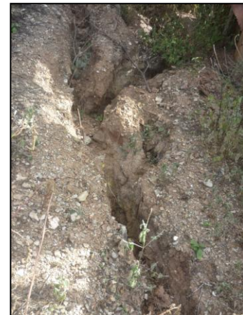
Fotografía 10. Socavamiento por escurrimiento fluvial
