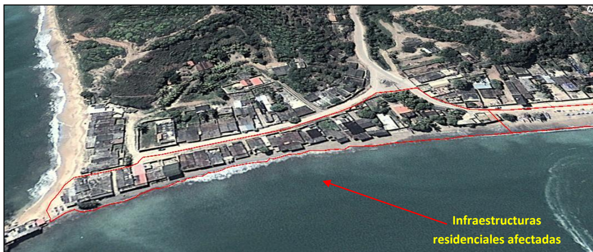
Figura 9. Construcciones ubicadas cerca de la línea de costa // Fuente: Google Earth, 2013.
