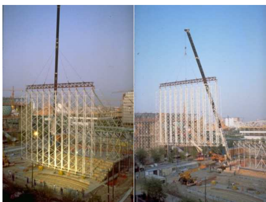
Figura 13 Colocación de la Malla Estructural.
