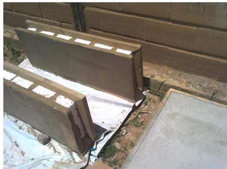
Figura 2: Paneles del Sistema VICOCA
