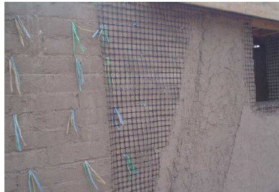
Figura 9: Friso reforzado con malla de plástico
