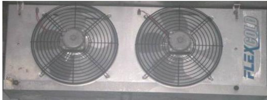
Figura 2.10: Unidad evaporadora.
