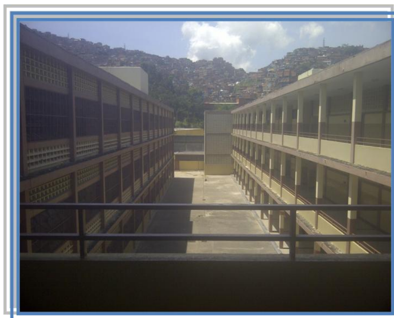
Fotografía 1. Patio central y torres del instituto educativo.
