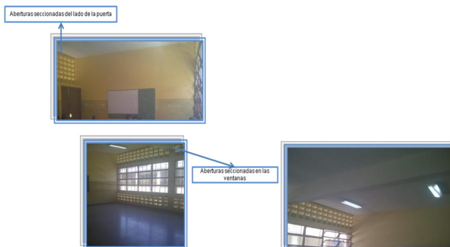
Fotografía 4. Aberturas seccionadas en las aulas e iluminación artificial.
