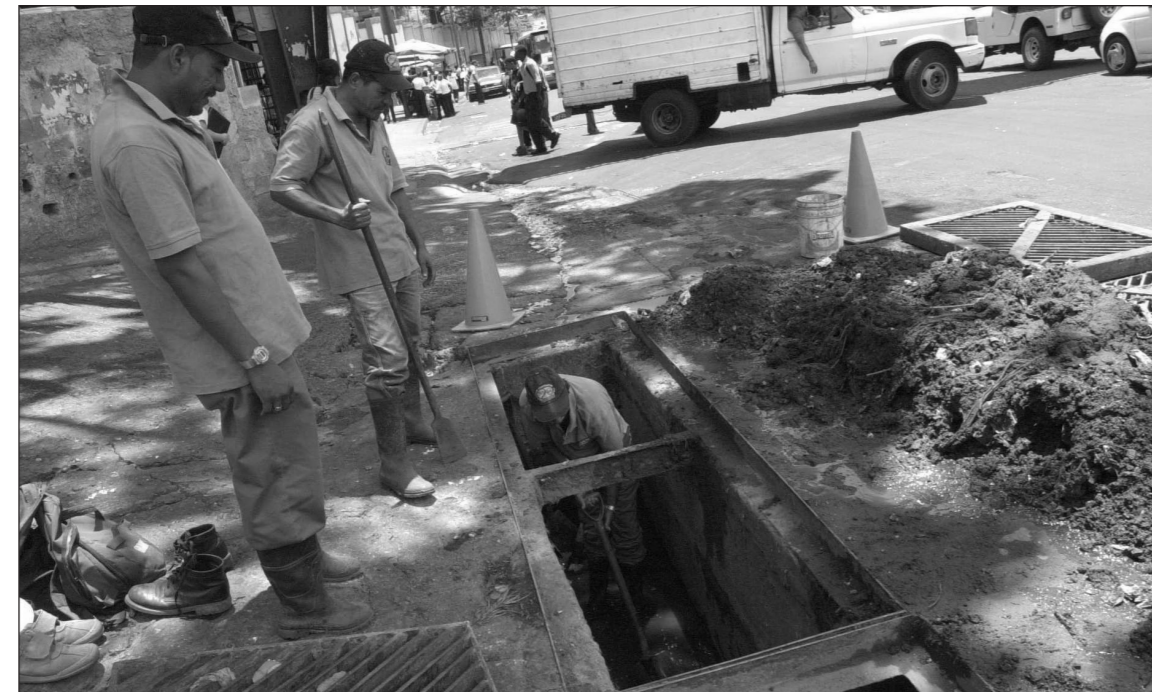
CVG empezó con la limpieza de alcantarillas colapsadas en el sector
