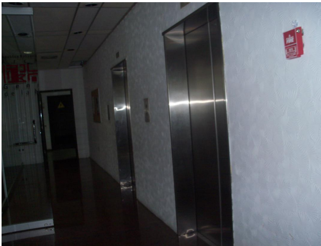
Figura 9.- Ascensores que llegan al nivel 1 donde se ubica la sala de consulta del AGN.
