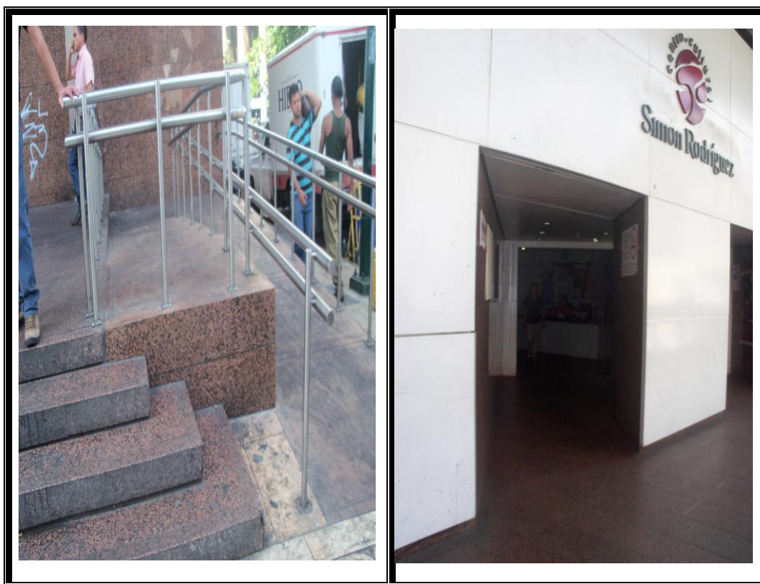
Figura 17 y 18.- Rampas de acceso y entrada a la torre anexa del Ministerio de Ciencia y Tecnología, donde se ubica el FONACIT
