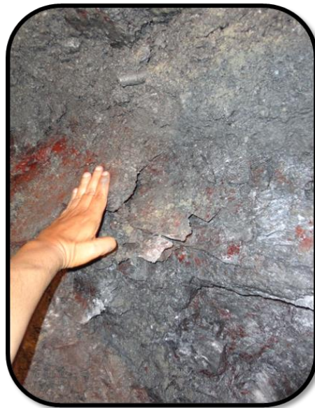
Figura 2.8 Avance de la obra, estación Bello Monte
