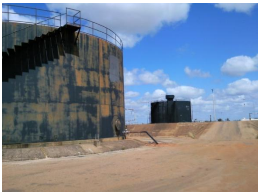
Figura N° 5. Tanque de lavado TK-40.001
