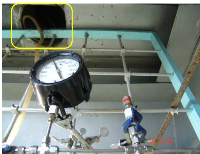
Figura N° 33. Posición de la válvula de alivio de presión.
