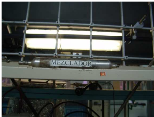
Figura N° 23. Mezclador antes del ensamblaje de la planta
