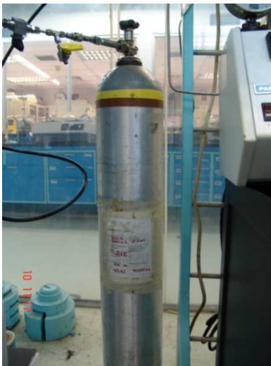
Figura N° 41. Cilindro de la Mezcla N_2/H_2S instalado en la Planta
