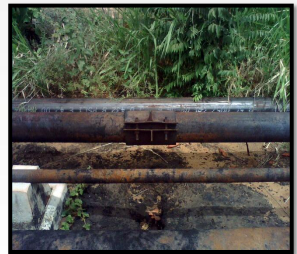
Corrección de fuga en línea de pozo aérea de 6"
