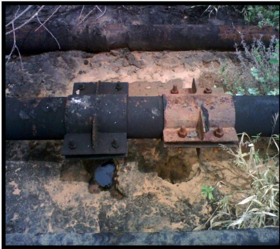
Corrección de fuga en línea de pozo aérea de 4"
