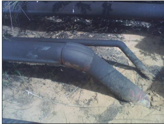
Figura N° 31 Corrección en codo con grampa pozo LM-427
