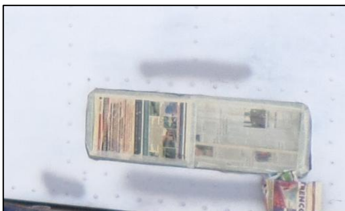
Figura 8. Aplicación de masilla blanca
