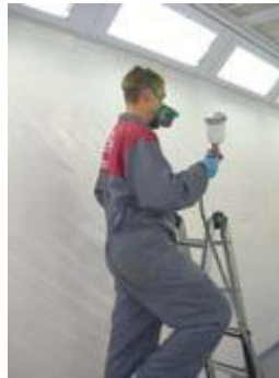
Figura 42. Riesgo de caída por aplicación de productos a distinto nivel.
