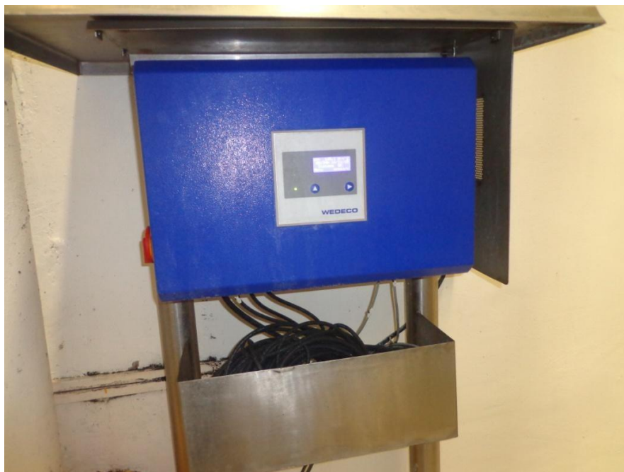
Panel de control de filtro uv
