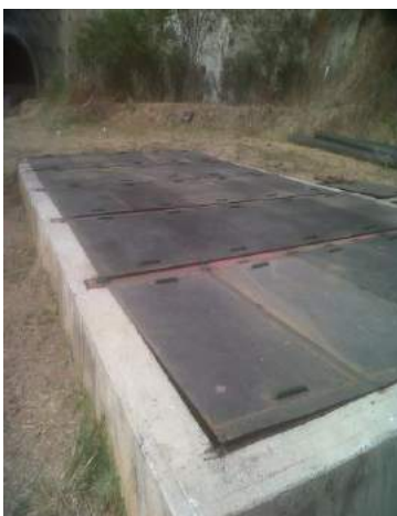
Vista de la fosa de captación capacidad 128 m 3
