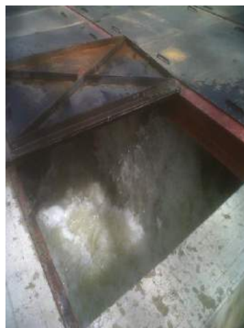
Vista 02 de la fosa de captación capacidad 128 m 3
