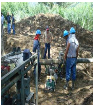
Vista de tubería secundaria PEAD 110 -250 mm instalada
