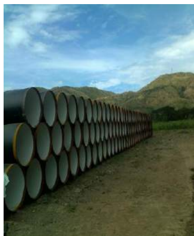
Vista tubería matriz Acero carbono D=36" pulgadas instalada.
