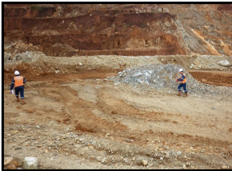
Figura 28. Área de giro – vía interna escombrera
