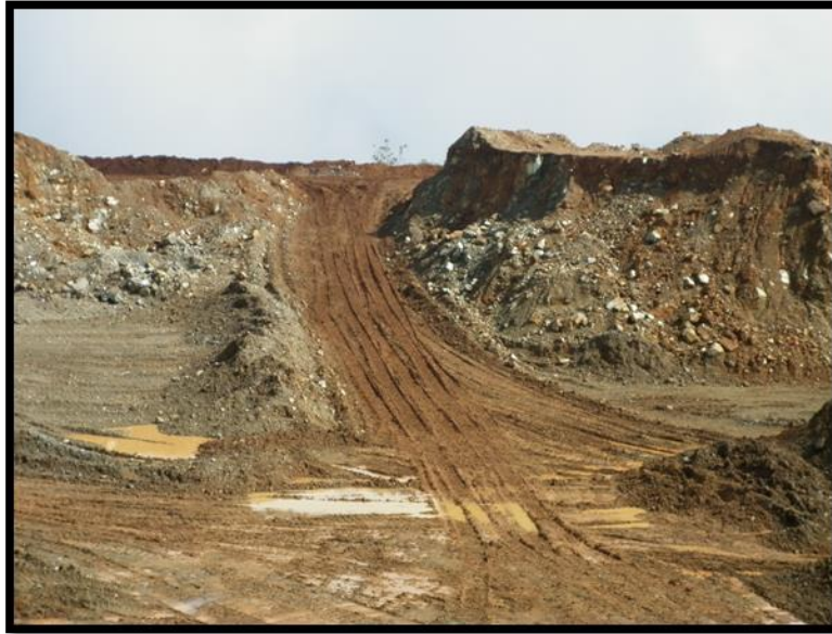
Figura 26. Vía de acceso nivel 1.280 Sector 2
