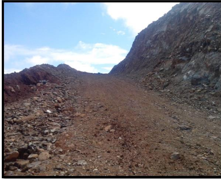
Figura 18. Acceso patio de retrolleado 01 (Vista desde el patio)
