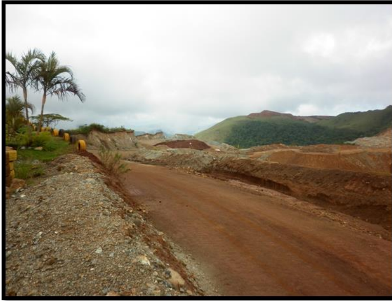
Figura 29. Vía de acceso Sur - escombrera
