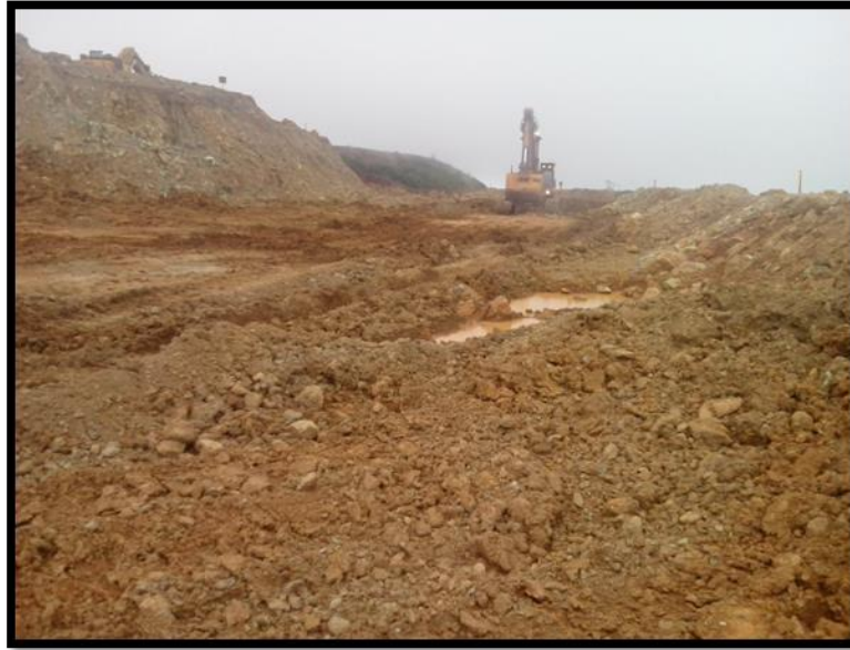
Figura 21. Frente de extracción nivel 1.305 (Aragua)
