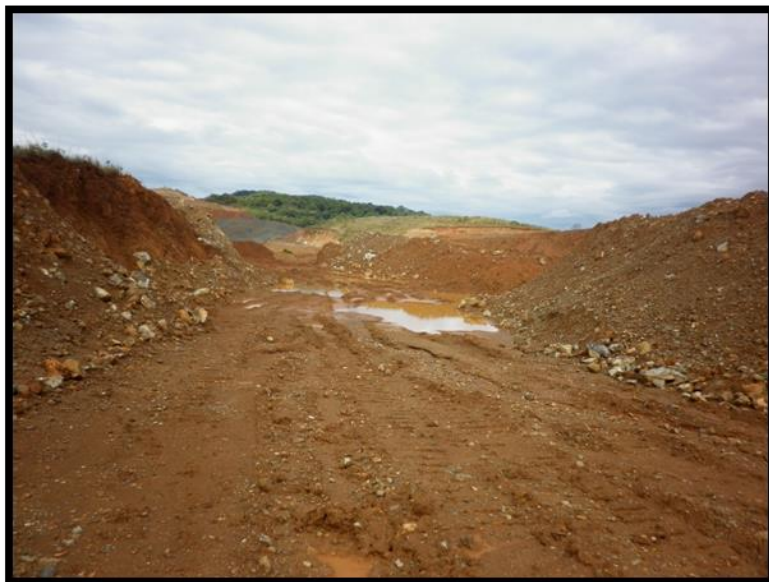
Figura 34. Patio 3 – Vía interna
