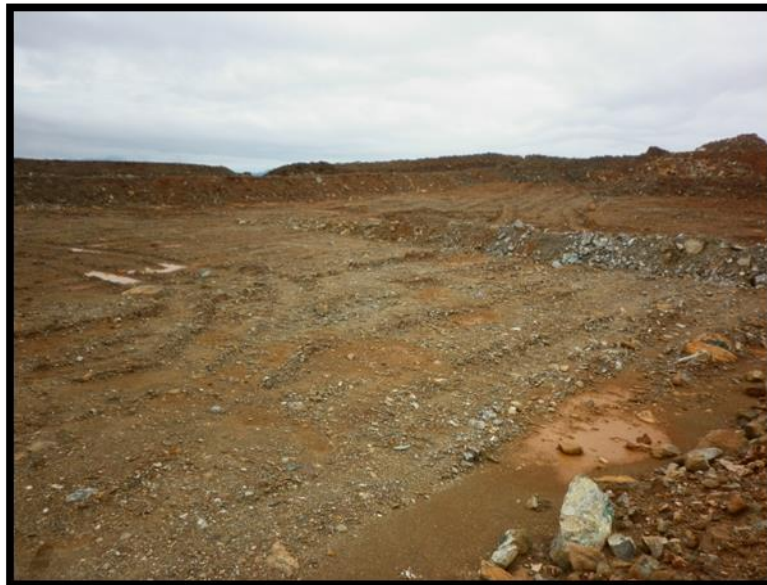
Figura 22. Frente de extracción nivel 1.315
