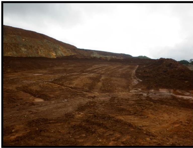
Figura 31. Frente de descarga – Escombrera
