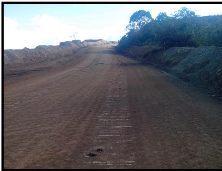
Figura 23. Vía principal Sector 2 (Capa Vegetal)
