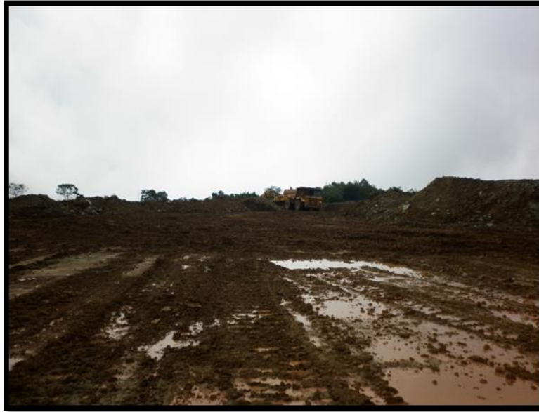
Figura 30. Frente nivel 1.260 – Frente operativo
