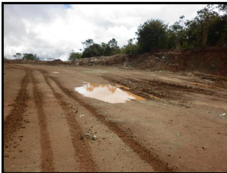
Figura 25. Vía de acceso nivel 1.265 (Agua Amarilla)
