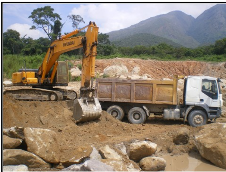
Figura N° 18. Carga sencilla por encima de nivel para retroexcavadoras. Fuente: Propia
