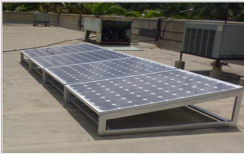
Figura B: Paneles instalados
