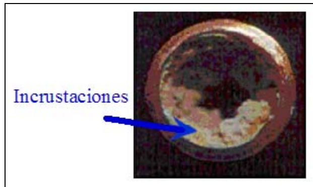
Figura N° 7. Incrustaciones en tuberías de producción. Fuente: RAPIDMATIC, 2007.
