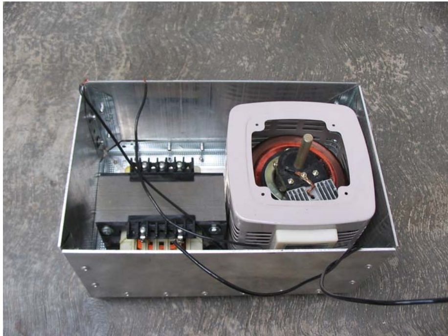
Figura 4.7. Instalación del variac y transformador
