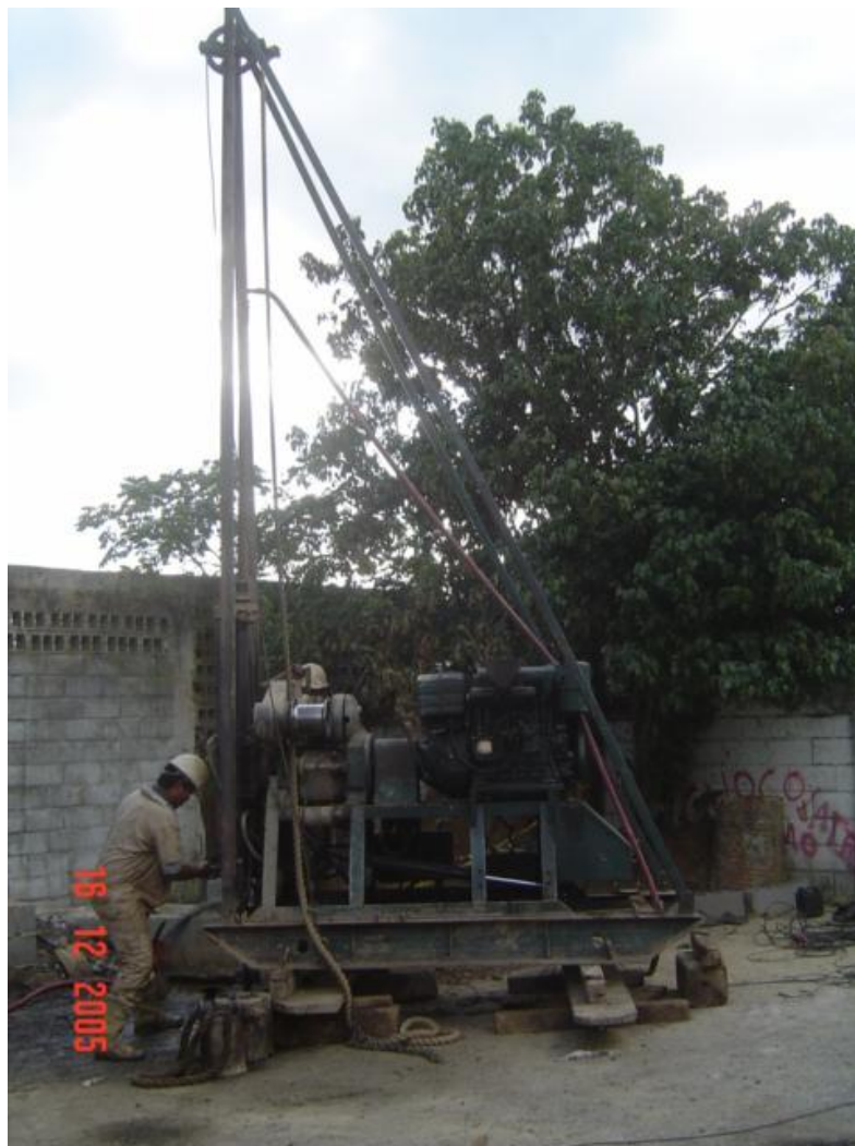
Figura 35. Equipo de Ensayo SPT utilizado en el sector Sebucán.
