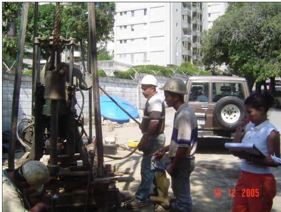
Figura 28. Equipo utilizado para el Crosshole en La Escuela de Enfermería de la U.C.V., sector Sebucán. A la izquierda: Máquina de perforación geotécnica.
