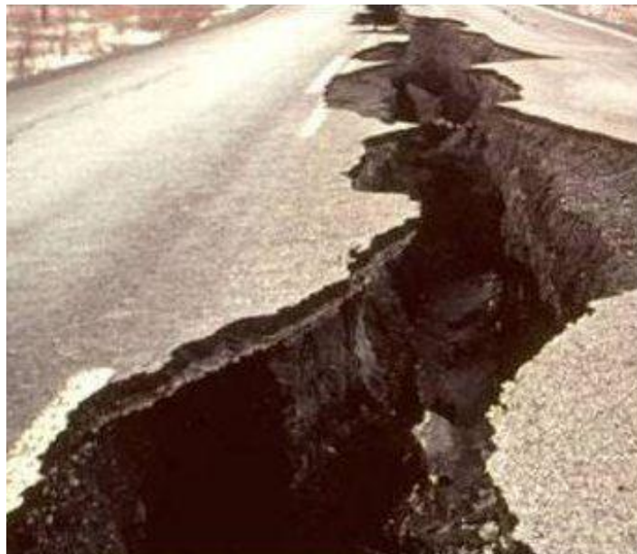
Figura 3. Pérdida de capacidad portante
