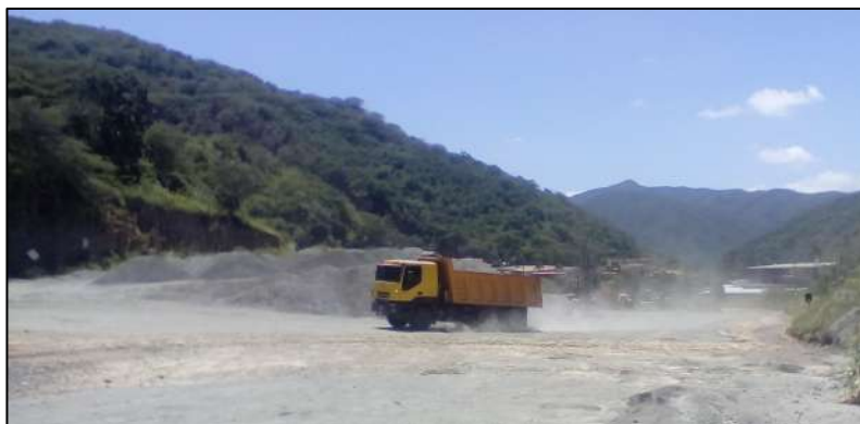
Figura 5.4 Suelo siendo compactado, debido al tránsito de vehículos pesados y al acopio de material.
