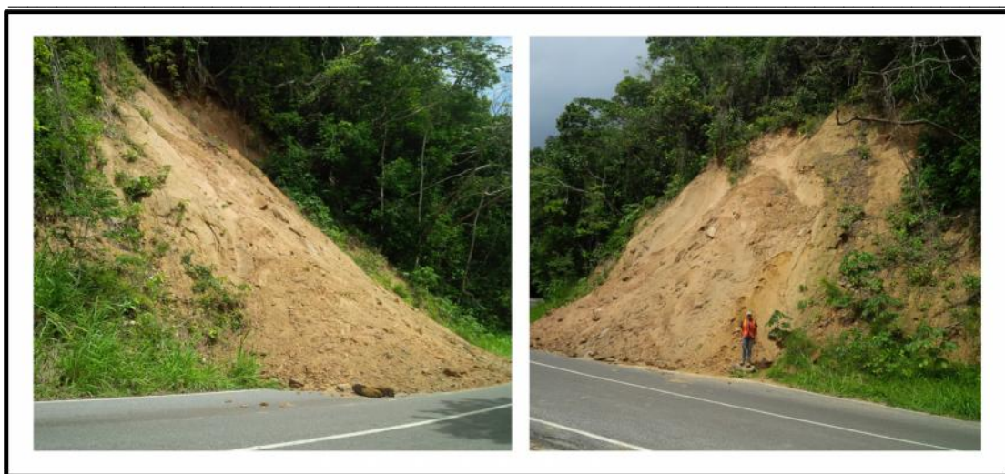
Progresiva: 22+370,6. Deslizamiento ocurrido en el talud superior, posterior a una precipitación. Obsérvese la afectación del canal de circulación.
