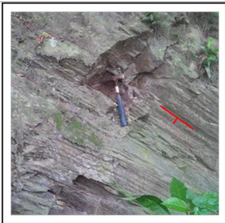
Progresiva: 27+817-Orientación de la foto: N25W
