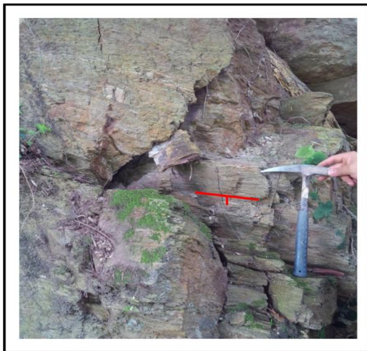
Progresiva: 24+524,9-Orientación de la foto: S15E:
