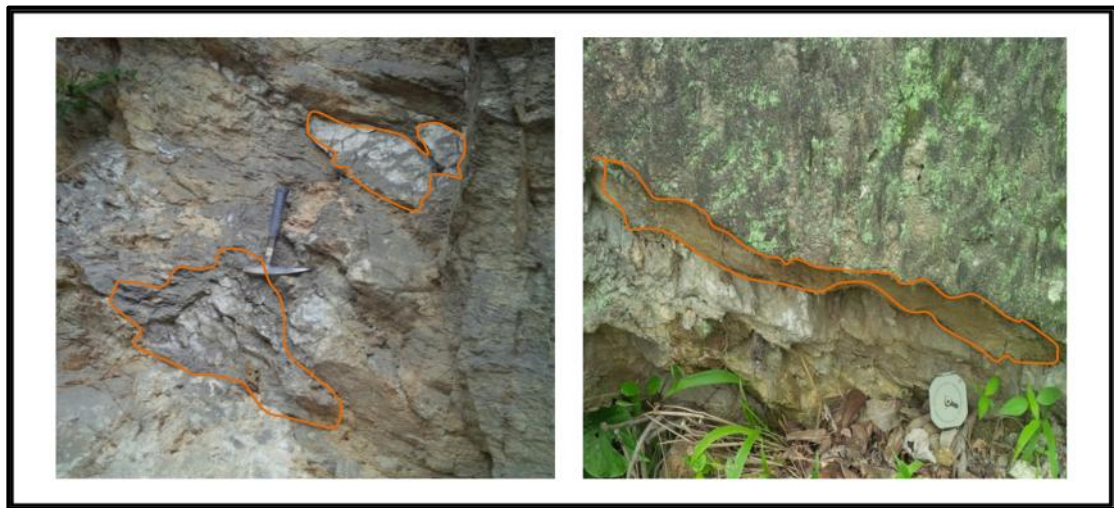
Progresiva: 21+169,8: Izquierda: Las vetas de cuarzo se encuentran rellenando los espacios entre las diaclasas, Derecha: veta de cuarzo paralela a la foliación.
