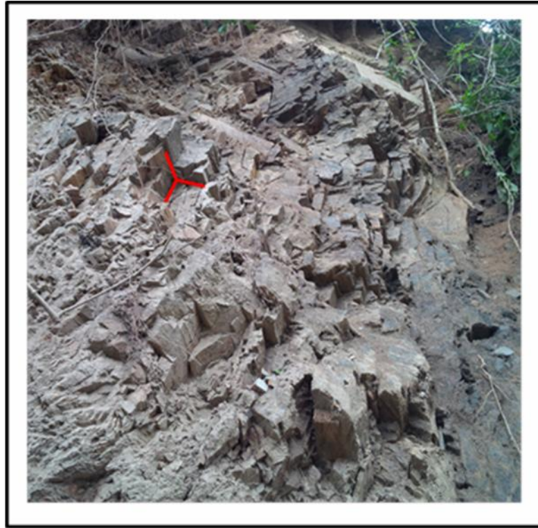
Progresiva: 23+500- Orientación de la foto: N10E
