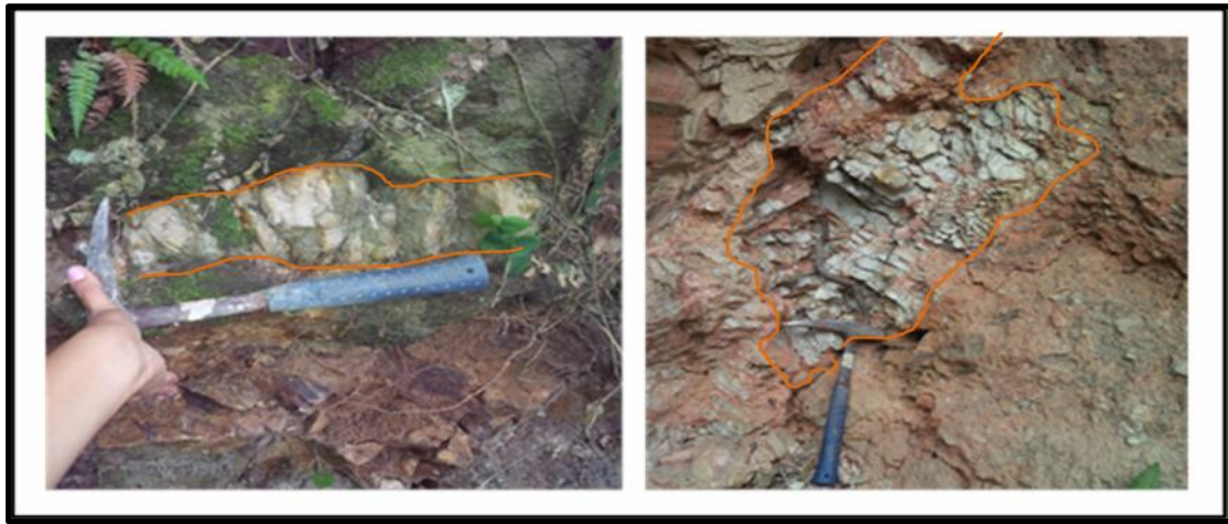
Progresiva 19+105,2: Izquierda: Veta de cuarzo con la misma orientación de la foliación. Derecha: Veta de cuarzo disgregada (Alto grado de meteorización).
