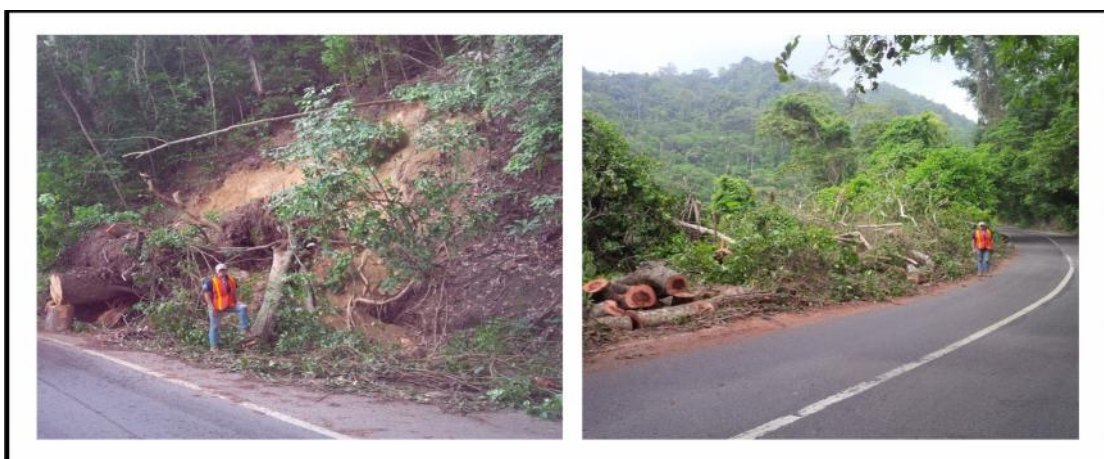
Talud altamente meteorizado, afectado por un fuerte deslizamiento, ocasionando la caída de la vegetación.
