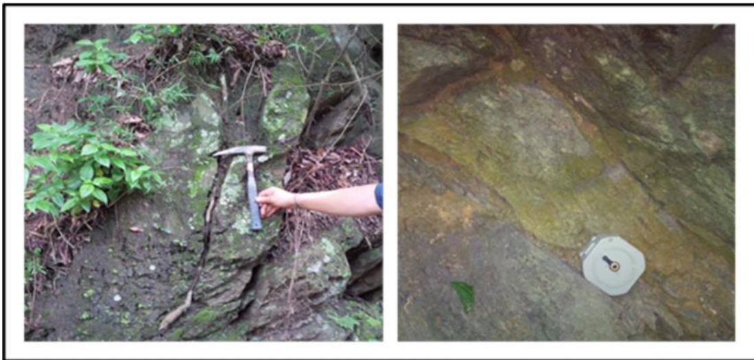
Progresivas: 22+847,9 y 26+536,1: Izquierda: Raíz de un árbol rellenando el espacio entre diaclasas. Derecha: Diaclasa rellenada con material arenoso, debido a la meteorización generada por las aguas intersticiales.
