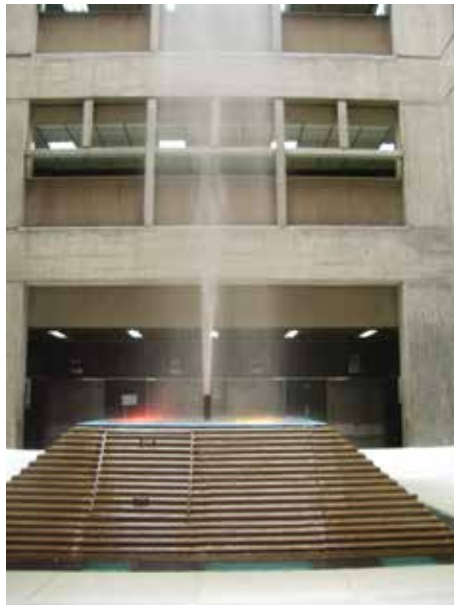
10. Hospital Domingo Luciani, IVSS, Caracas. Patio interior, fuente. Foto del autor (2010)
