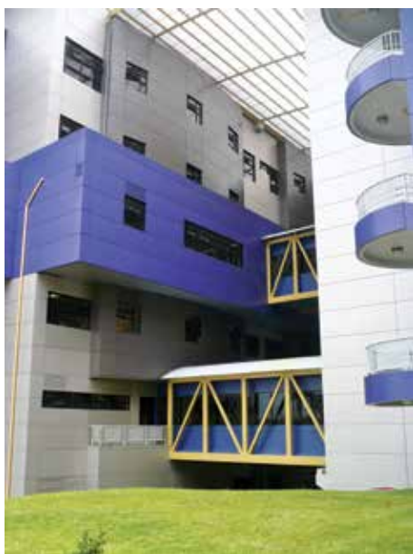
15. Hospital de Heredia. San José de Costa Rica. Foto del autor (2010)
