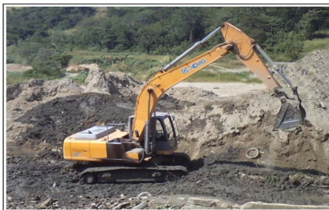
Figura N° 24. Excavadora Marca XCMG modelo XE230. Fuente: Foto propia.
