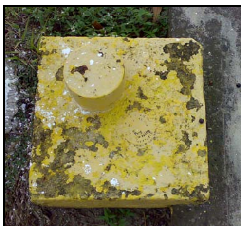
Figura 4.6. BM de estación base 9712-70 ubicada dentro del Aeropuerto Nestor Arias de San Felipe, estado Yaracuy (Foto tomada por Fátima Gomes)
