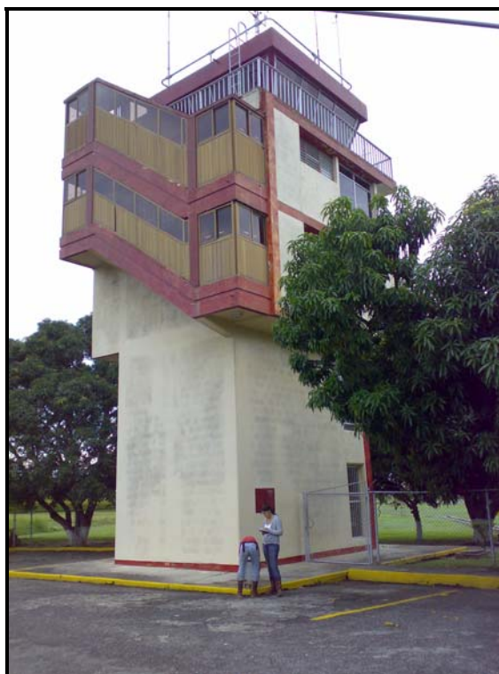
Figura 4.7. Estación base levantada en la torre de control del Aeropuerto Néstor Arias de San Felipe, estado Yaracuy. (Foto tomada por Fénelix Martínez)
