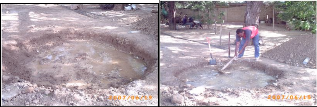
Figura 54. Apertura de agujeros destinados a la construcción (fotografía de Piñero V., 2007).
