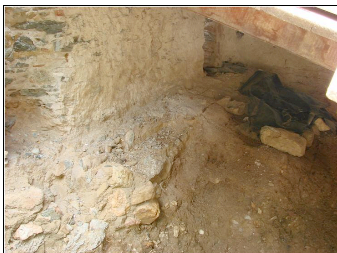
Figura 48. Excavación en la base de la torre (Fotografía de Vertullo G.).
