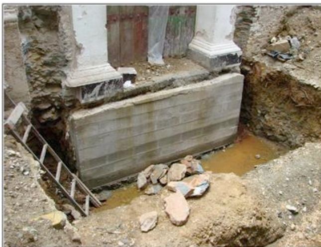
Figura 61. Excavación en la entrada lateral del templo (Fotografía de Vertullo G.).
