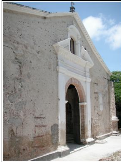
Figura 4. Situación actual de la fachada principal
