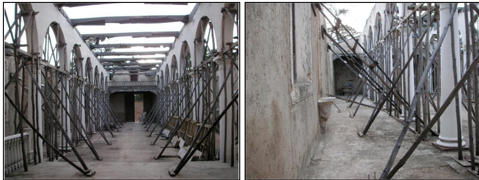
Figura 26. Apuntalamiento temporal en el interior del templo.
