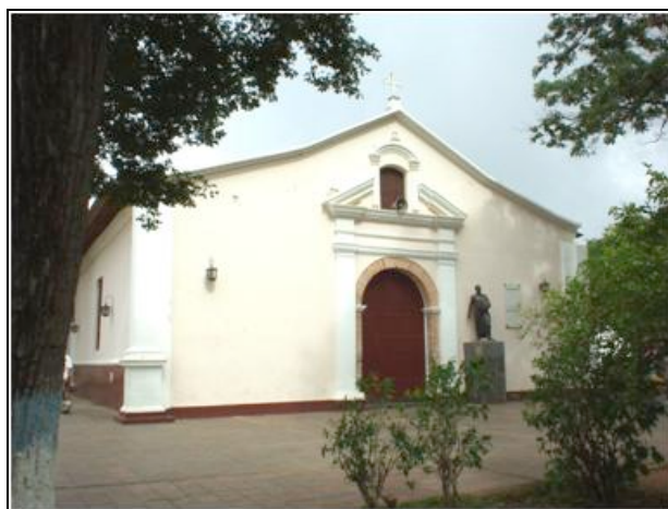
Figura 3. Fachada principal en el año 2003 (Tomado de Villarroel, 2003)
