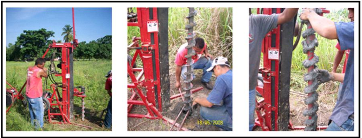
Figura 3.2. Perforación de pozo.
