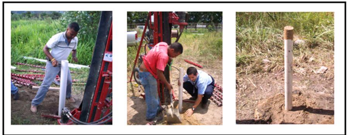
Figura 3.4. Encamisando el pozo.
