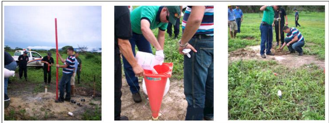
Figura 3.8. Colocación de la carga explosiva dentro del pozo.
