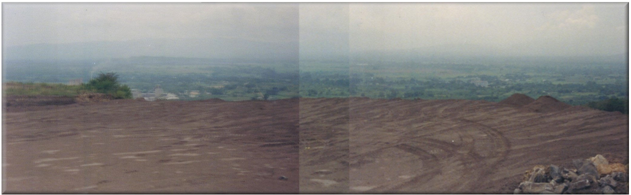
Figura 5.2. Fotografía de la Berma de la Escombrera de Finos.
