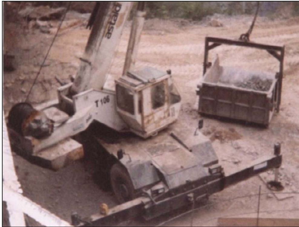
Gráfico 35 Carga de escombros con grúa telescópica T106 MAIA 35
