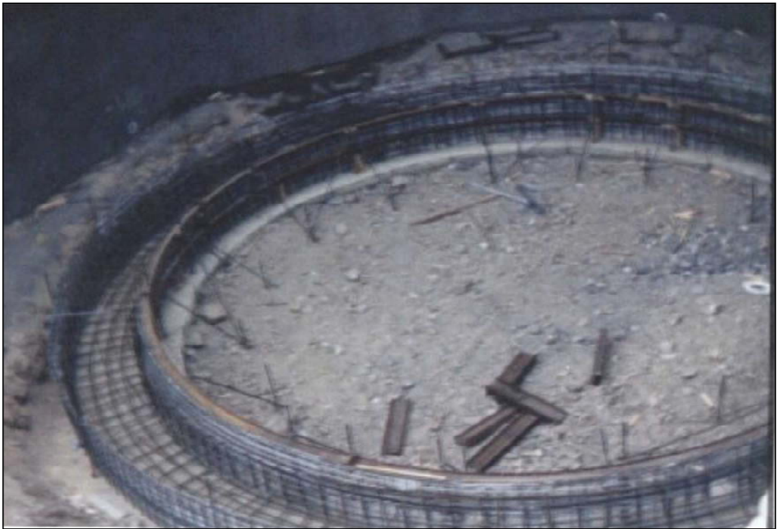
Gráfico 25.- Perspectiva de la Fabricación del Anillo Guía
