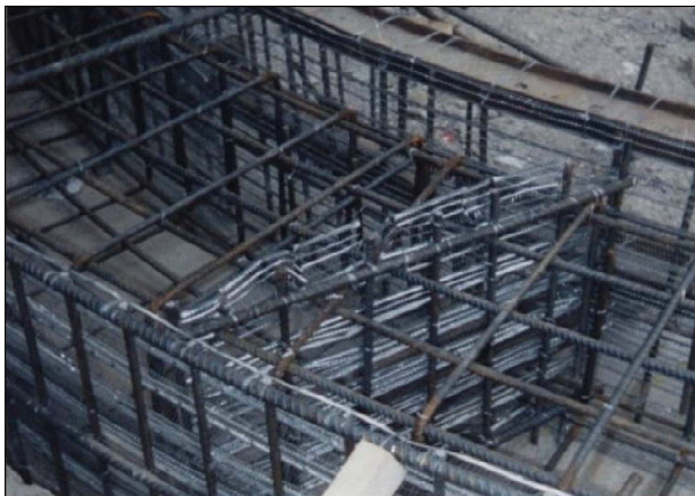
Gráfico 29.- Armadura de la Malla Riplex para los separadores de anime
