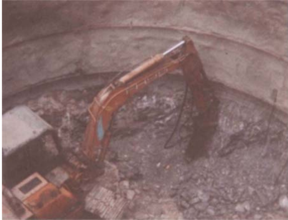
Gráfico 33.- Excavación mecánica con JUMBO de Martillo Demoledor
