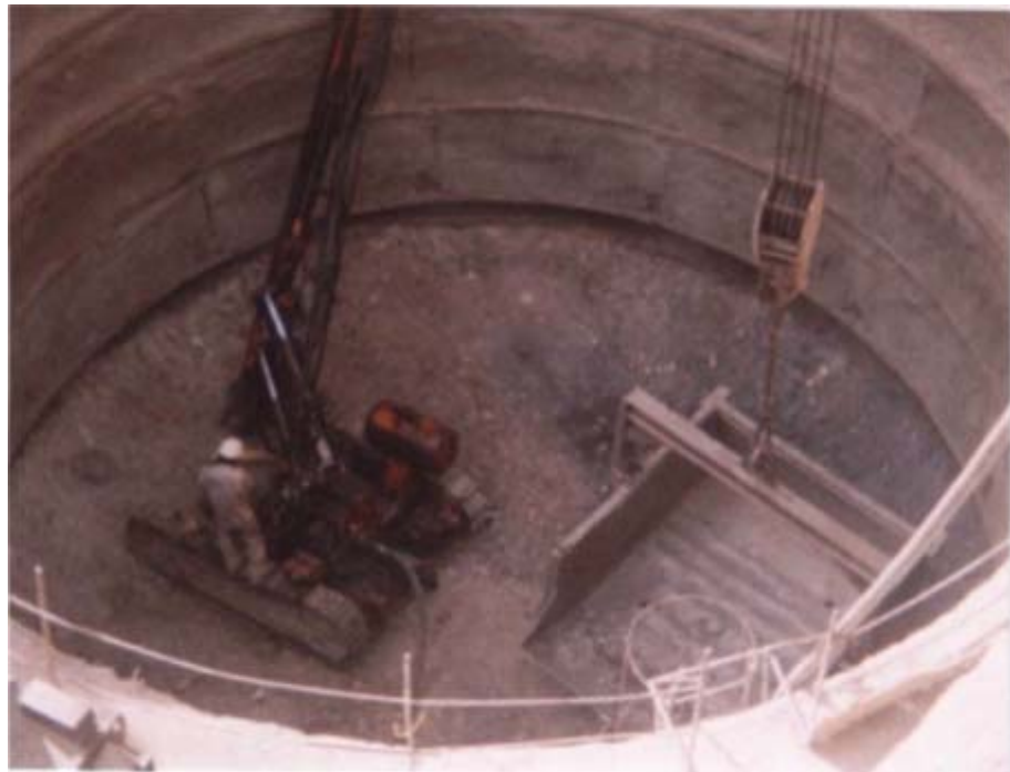
Gráfico 34.- Perforación con máquina neumática BAGODRILL
