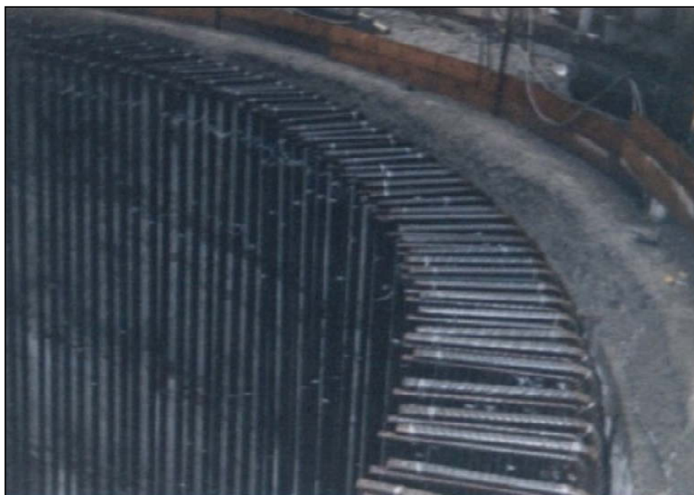
Gráfico 39.- Acero de refuerzo para la fundación
