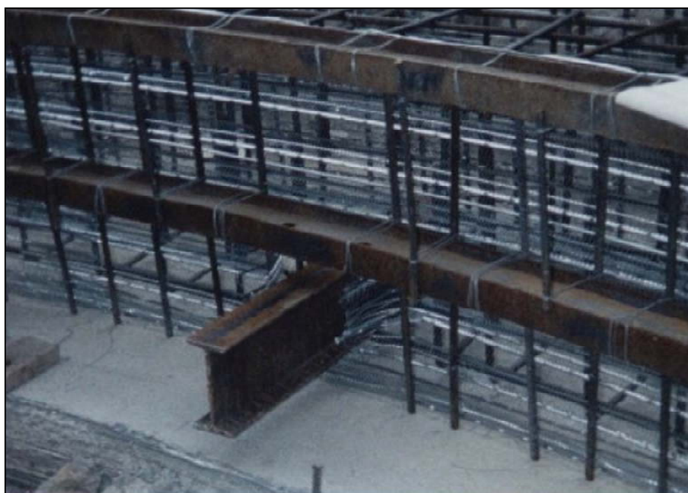
Gráfico 27.- Disposición de las vigas IPN 140 y la malla Riplex
