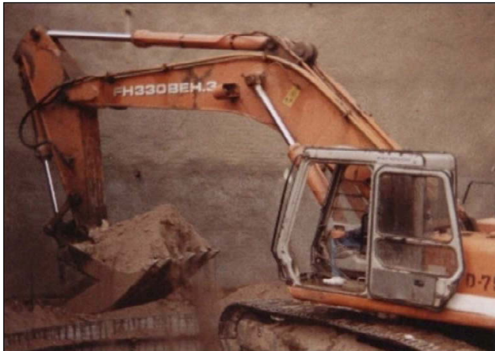
Gráfico 31.- Excavación mecánica con excavadora FIAT-HITACHI 0221
