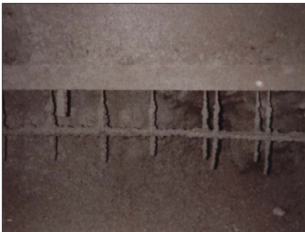
Gráfico 38.- Revestimiento del sostenimiento con concreto proyectado
