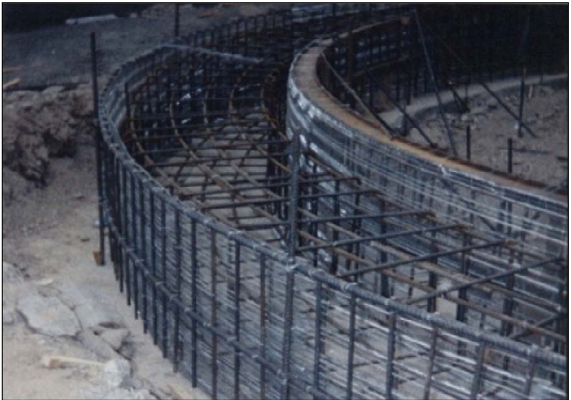
Gráfico 26.- Refuerzo en la Armadura del Anillo Guía
