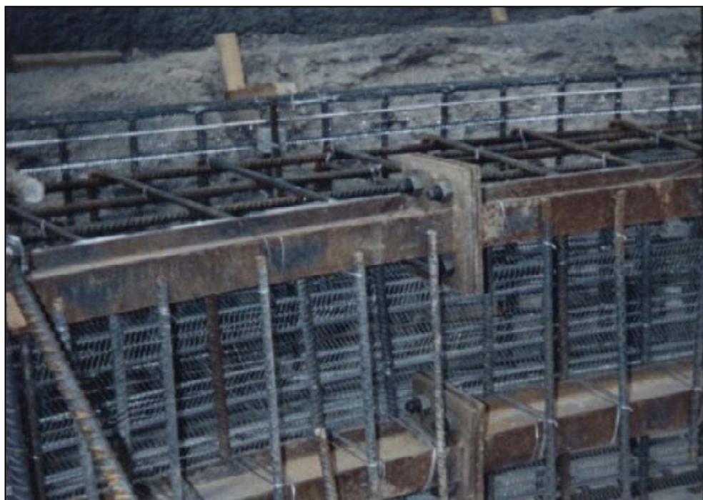
Gráfico 28.- Ensamblaje de las vigas IPN 140 con los Pernos
