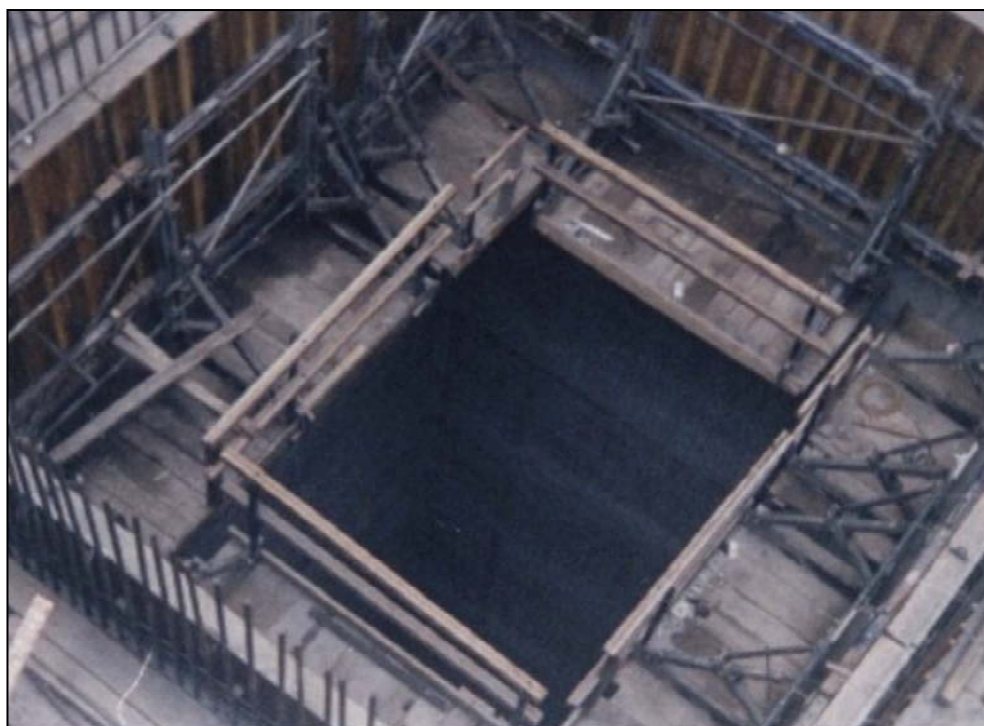
Gráfico 40.- Encofrado del pozo de fundación
