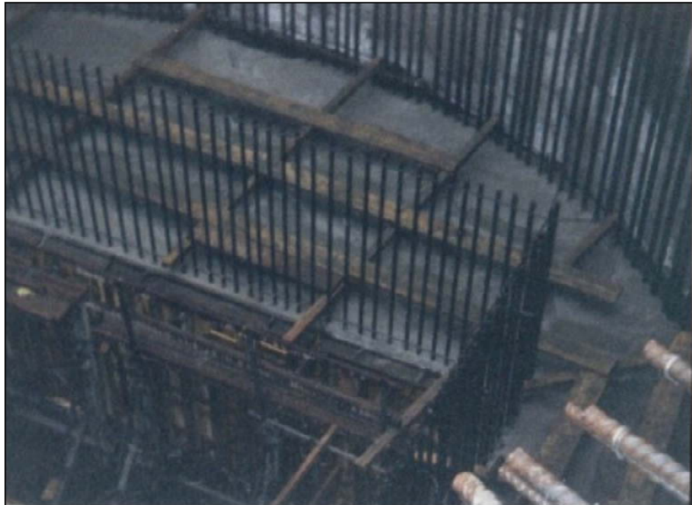
Gráfico 41.- Vaciado de concreto
